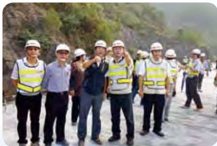
▲黃義佑執行長視察勤和至復興高架橋工程進度之橋面板澆注完成情形(2016.11.18)
