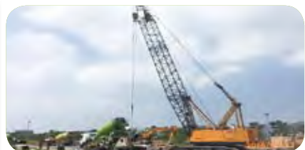
▲擋土牆基礎全套管基樁施工。
