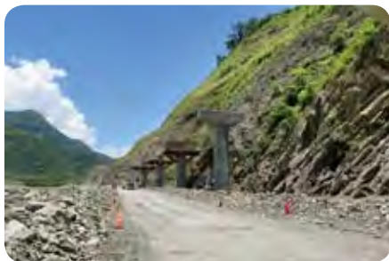
▲勤和至復興高架橋工程進度之橋墩完成情形(2016.7.20)
