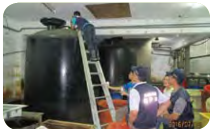
針對不法工廠，查證其廢水排放管線情形
