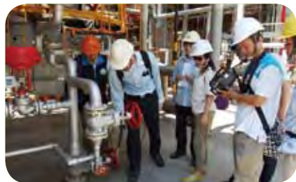
使用紅外線氣體顯像偵測儀深度查核石化廠揮發性有機氣體逸散情形
