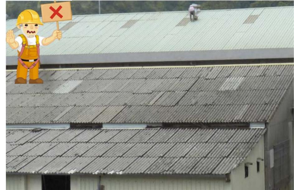
圖 49 於易踏穿材料構築及具傾斜面之屋頂作業時，未先規劃安全通道
