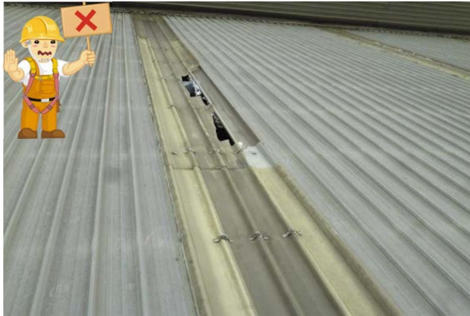
圖 47 於易踏穿材料構築之屋頂作業時，事先未規劃安全通道
