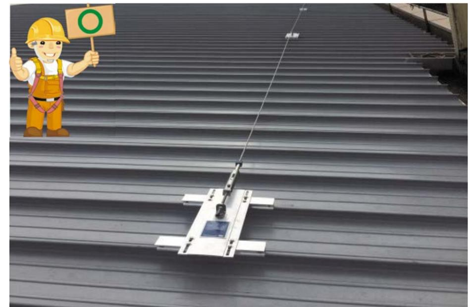
圖 54 ( 水平 ) 安全母索以鋼索材質設置，其最小斷裂強度應在 2,300 公斤以上
