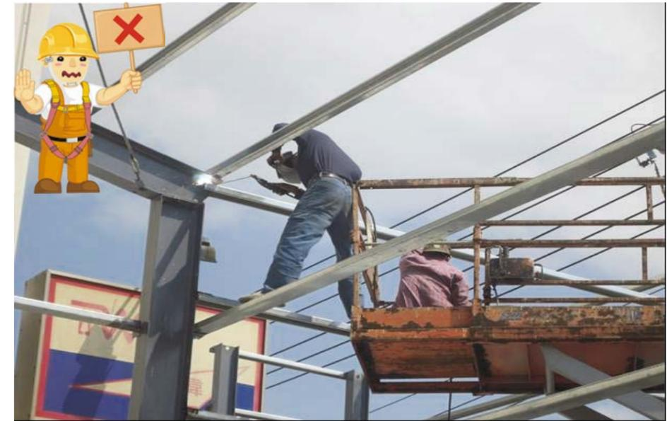
圖 45 勞工未於高空工作車之工作臺內實施作業，且未佩戴安全帶
