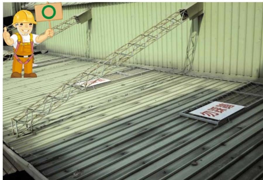
圖 52 易踏穿材質屋頂板，上方設置格柵板，並標示勿踩踏警示標語
