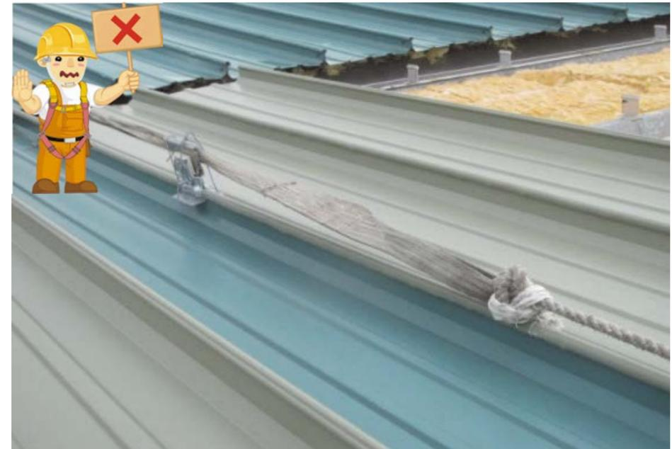
圖 53 設置之安全母索應為鋼索、尼龍繩索或合成纖維之材質，並不得使用綁紮方式進行連接
