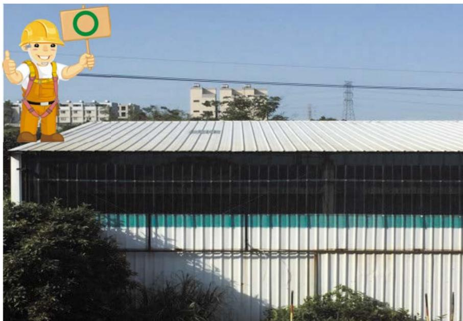
圖 44 將採光罩設置於側牆，原採光罩位置以彩色鋼板鋪蓋，減少人員墜落風險
