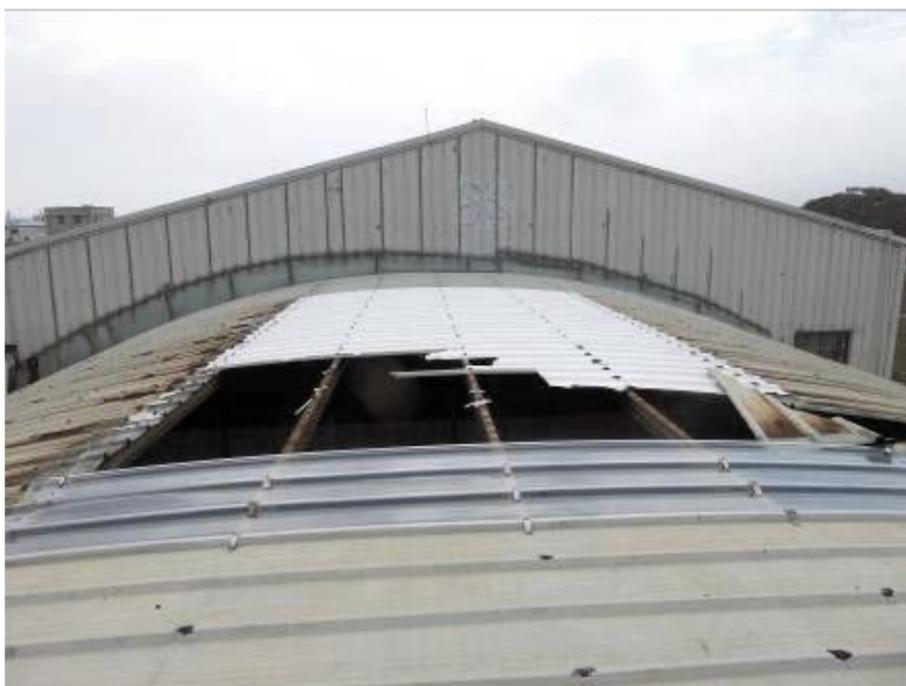
圖 9 易踏穿材質屋頂破裂情形
