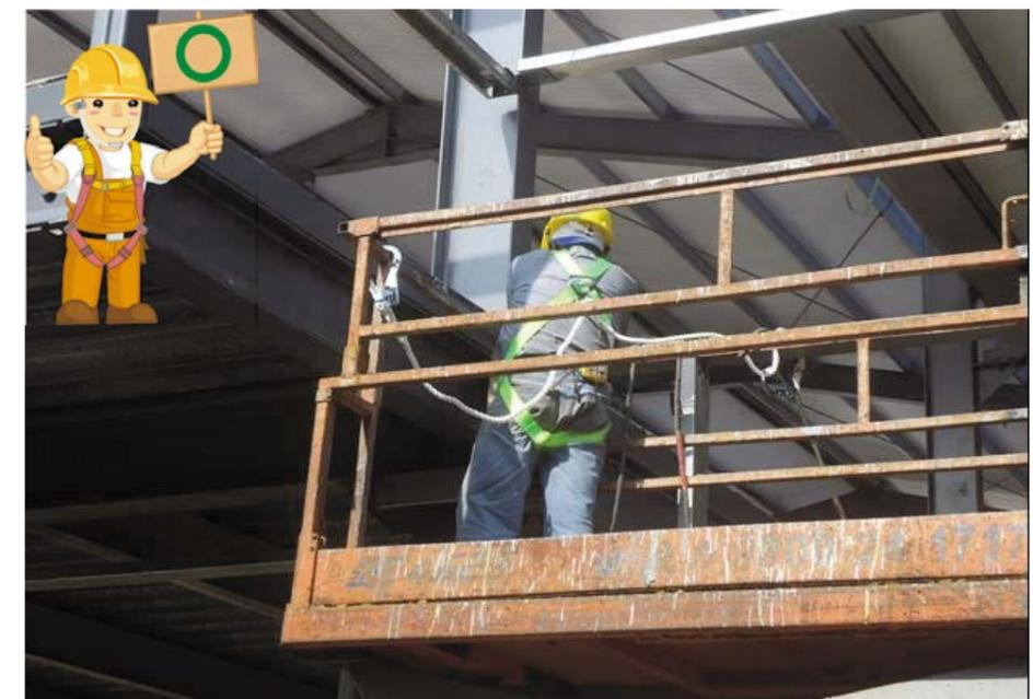
圖 46 於高空工作車之工作臺內實施作業，並確實佩戴安全帶及鈎掛堅固物件上
