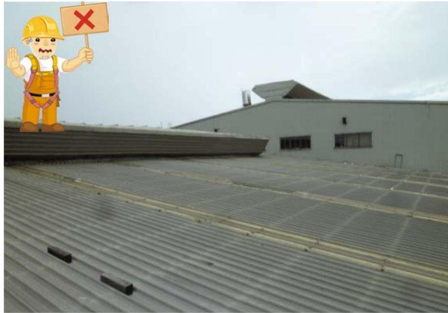
圖 43 塑膠採光罩經日曬雨淋及積塵已不易辨識位置，人員於屋頂作業時容易誤踩踏穿，致由該處墜落
