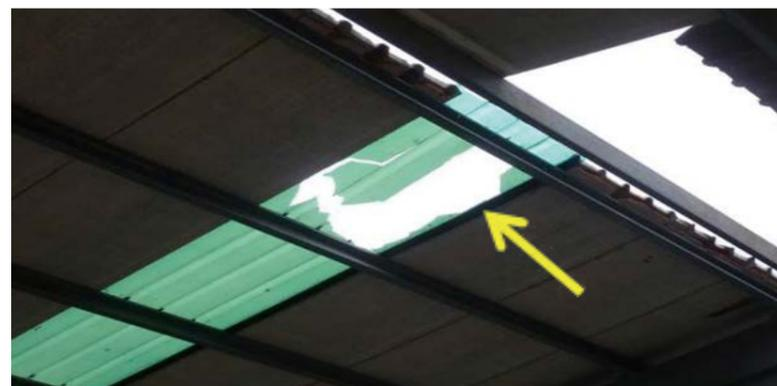
圖 5 踏破之採光罩開口處
