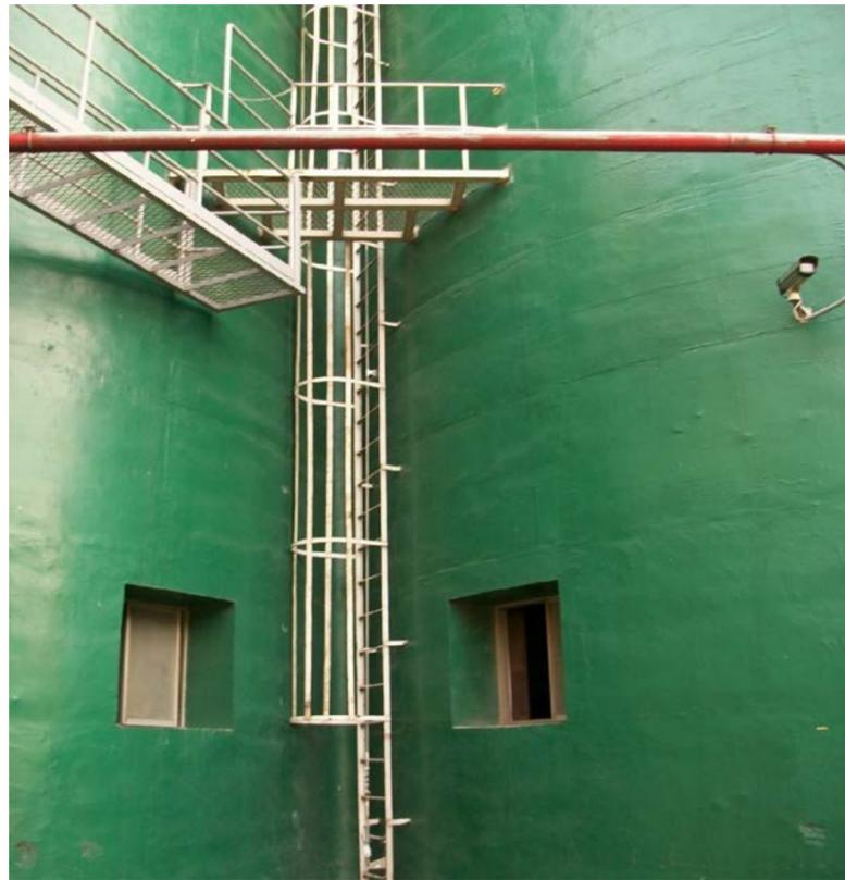
圖 31 高度 2 公尺以上之護籠爬梯，設置垂直母索示意圖
