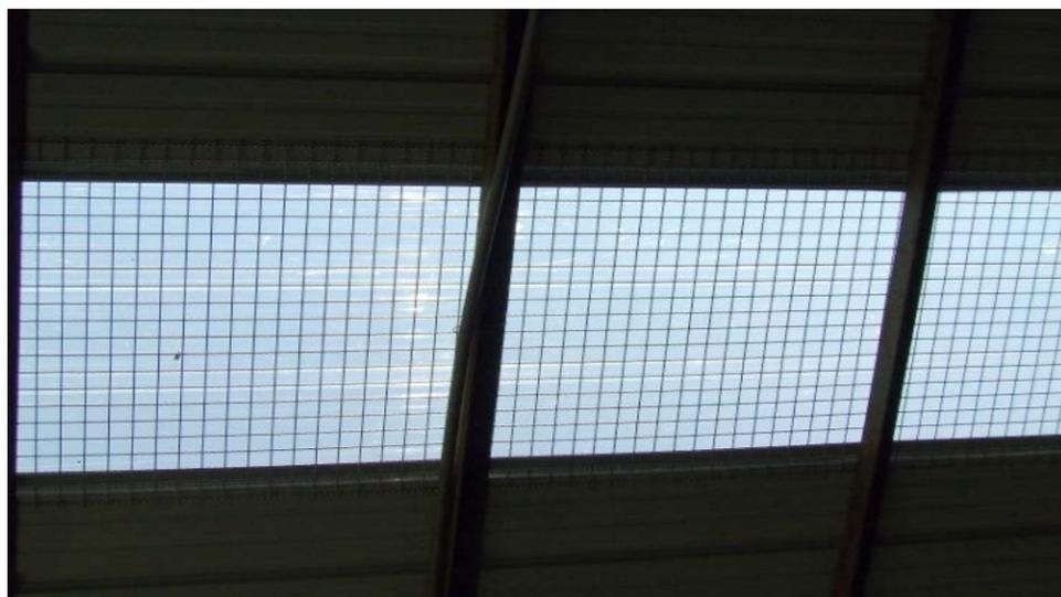
圖 36 廠房屋頂下方格柵網示意圖
