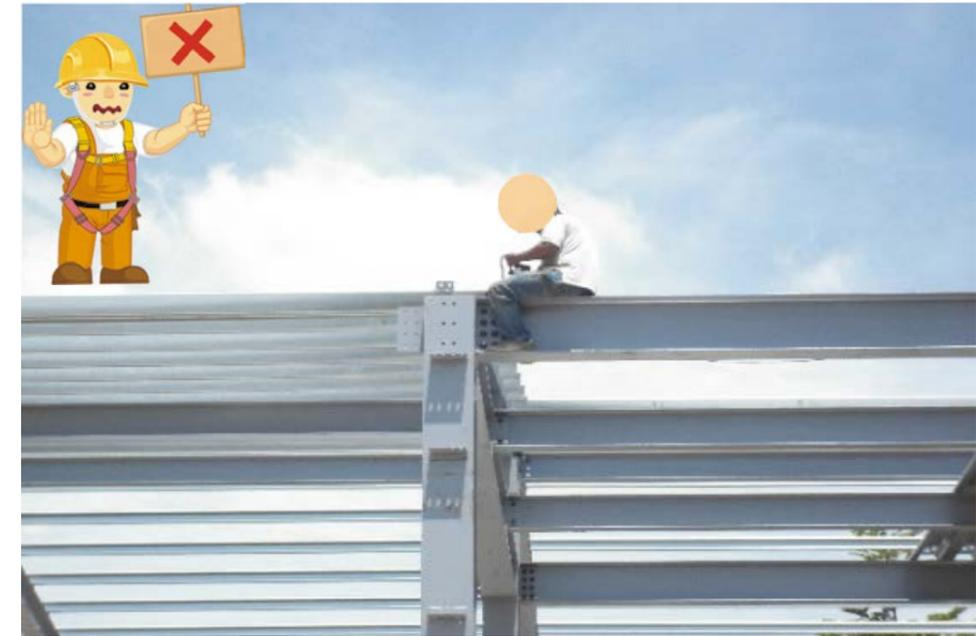
圖 41 跨坐鋼構上作業，未提供或使勞工確實繫掛安全帶
