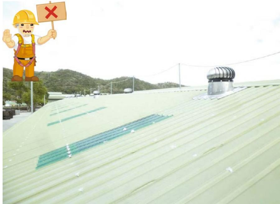
圖 51 人員欲進行易踏穿材質 ( 塑膠 ) 屋頂板作業時，未設置防止人員踏穿墜落之安全防護措施
